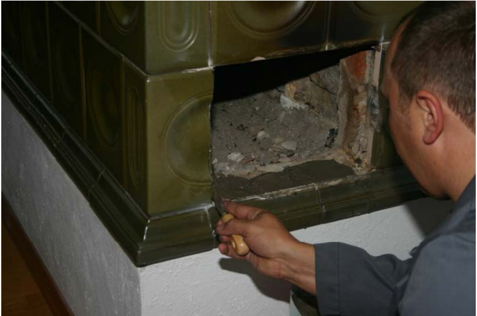
Haftheat auf Einbaustelle
