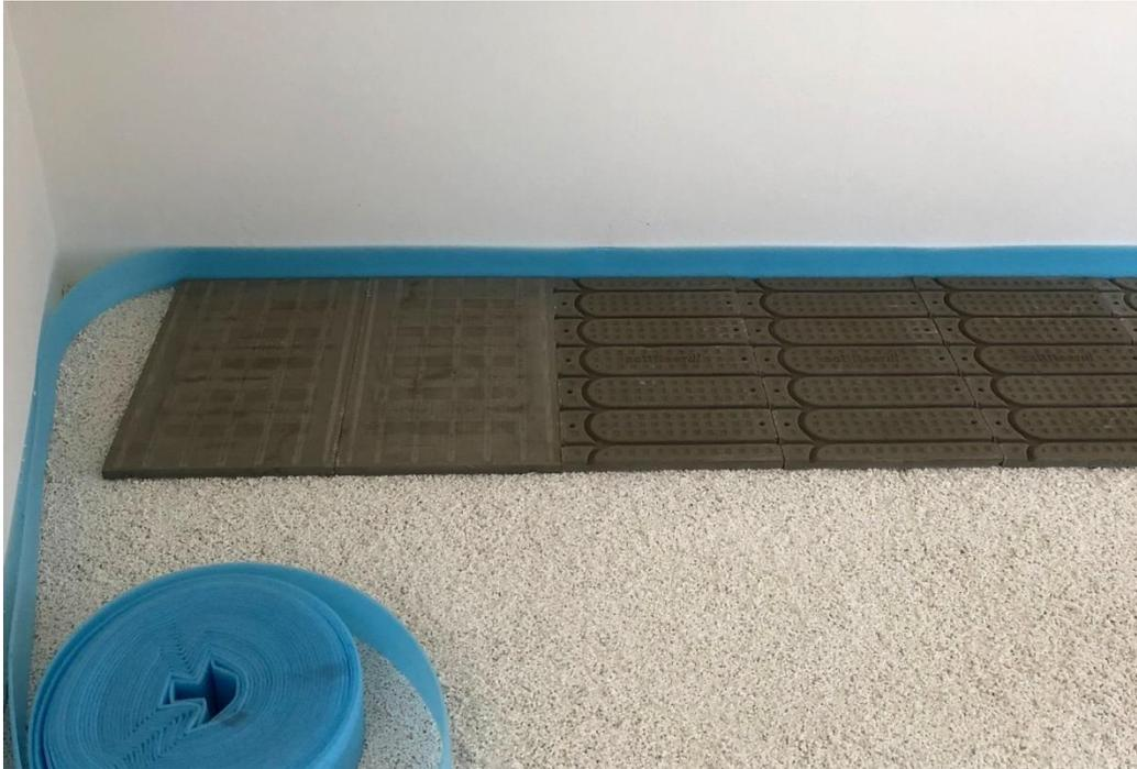
Die Wärmeleitplatten der ACTIFLOOR-Flächenheizung wurden direkt auf die spezielle Dämmschüttung verlegt. Durch die Bauweise ohne Estrich können Kosten und Zeit gespart werden.
